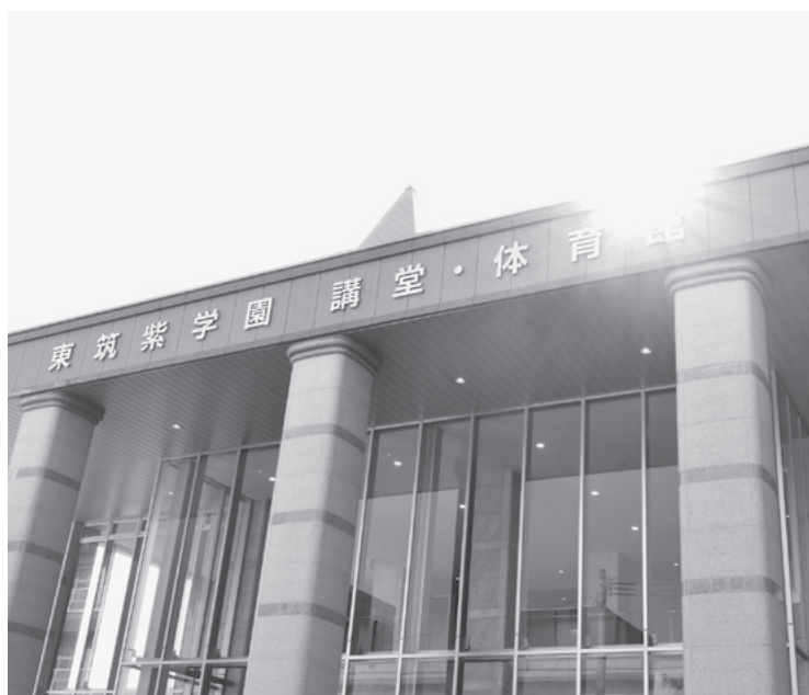
平成三十一年一月二十三日 新講堂体育館の入り口の工事中足場の道路側先端が外れ 東筑紫学園講堂体育館入り口の館名文字が陽光に輝く日
